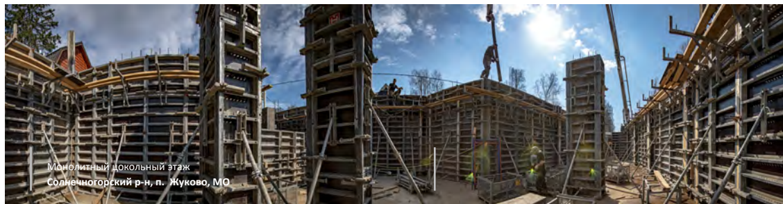
Монолитный каркас дома и монолитное перекрытие П. Расторопово, МО
