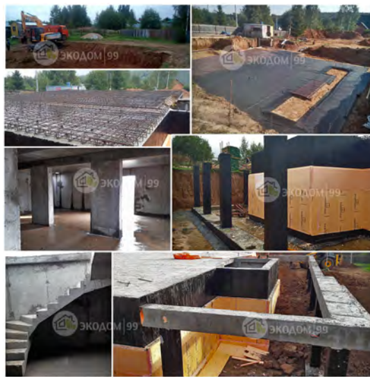
Монолитный цокольный этаж Алексино, МО
