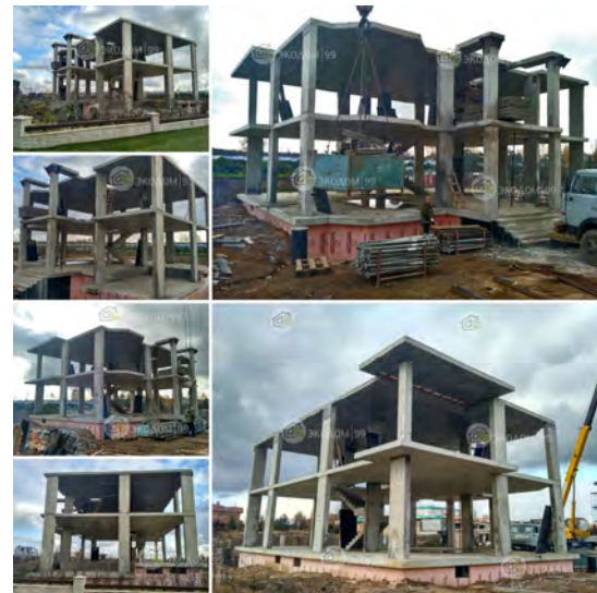
Цокольный этаж и монолитный каркас, 280 м 2 кп. Милениум парк, МО
