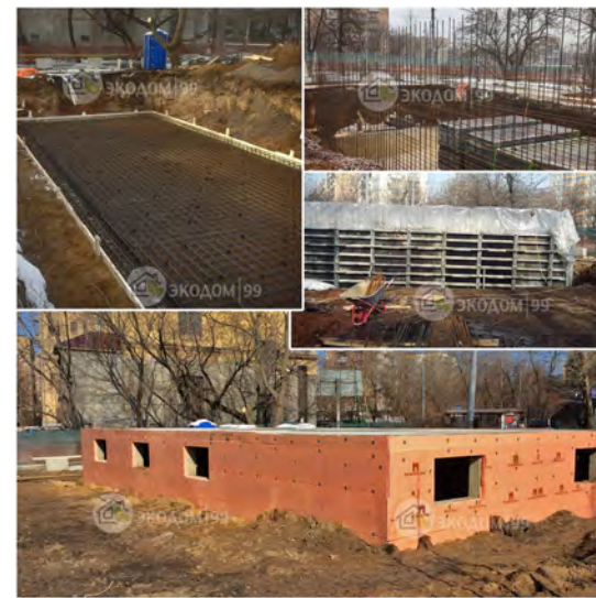
Монолитный цокольный этаж Масловка ул., Москва
