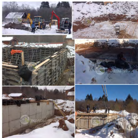
Монолитный цокольный этаж КП Тургеневские дачи, МО
