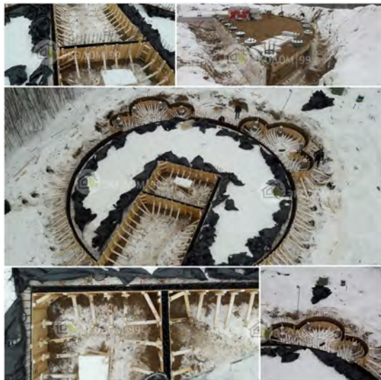
Монолитная плита на сваях Дубна, МО
