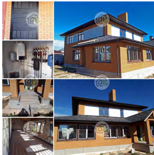
Газоблок Ytong + облицовочный кирпич, 360 м 2 п. Серебряная подкова, МО
