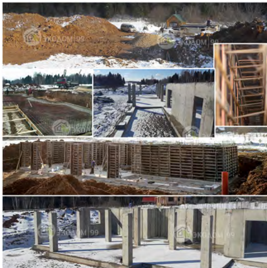
Монолитный цокольный этаж п. Мамошино.ком, МО
